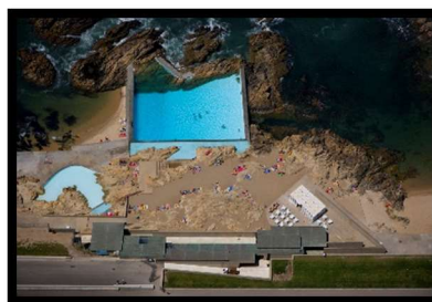
Εικόνα 29: Leça da Palmeira Swimming Pool (πηγή: www.archdaily.com )
