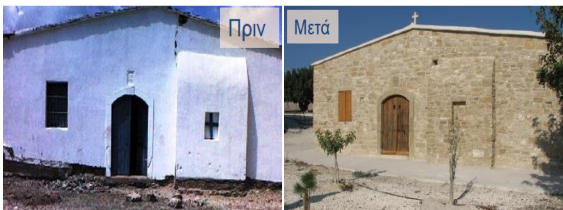
Εικόνες 1&2: Αποκατάσταση Εκκλησίας Αγίου Γεωργίου-Περιοχή Αναδάσμου Χοιροκοιτίας
