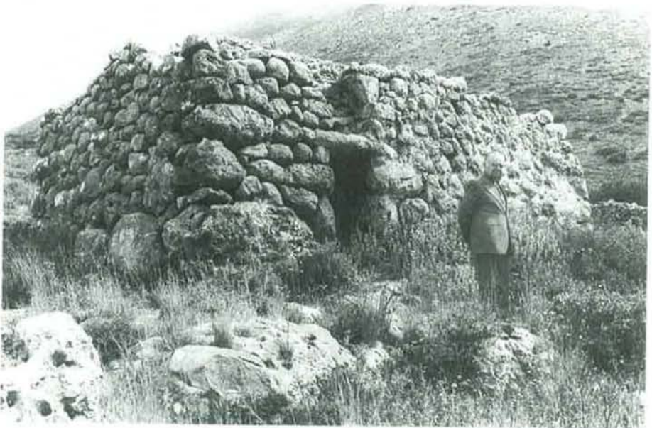
Εικ. 8β. Μάνη, Μίνα: Άι-Γιάννης στον Κοράκον. Ογκολιθική τοιχοδομία (φωτ. Αρχείο Ν. Β. Δραγιάκη, φ. 133, 1984)
