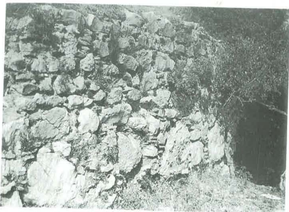
Εικ. 10. Ο βόρειος ανιερεισματικός τοίχος του περιβάλλον της μονής (το κεντρικό τμήμα).
