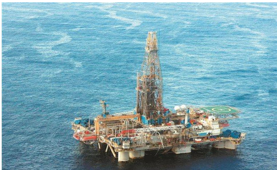
Εικόνα 1: Πλατφόρμα γεωτρήσανου με τις σχετικές εγκαταστάσεις και εξοπλισμό. 3
