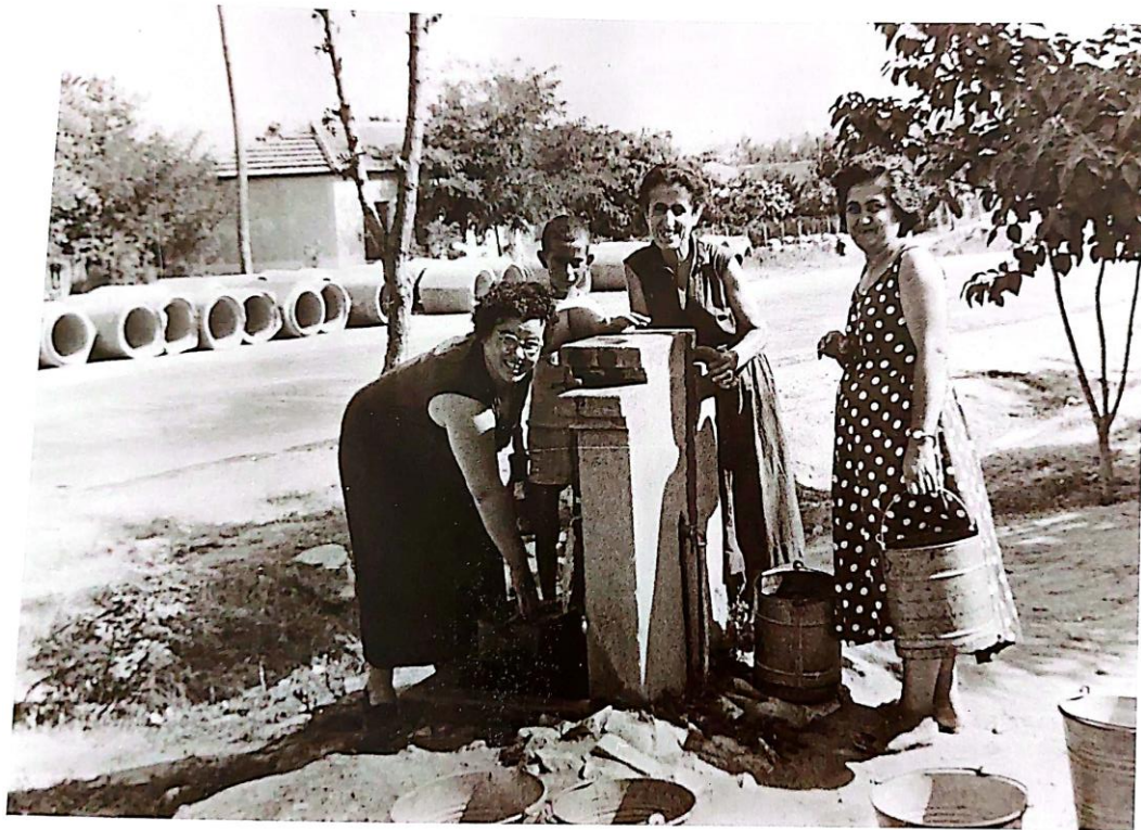
Καλαμαριά, 1950. Στην οδό Καλλίδου, στη δημόσια βρύση, μπροστά από το σπίτι του Σταμάτη Παραρά. Από αριστερά, η Ελένη Βιοπούλου, ο Γιάννης Μακρόπουλος, η μητέρα του Μαρίκα Μακροπούλου και η Κλαίρη Λαμπριανίδου. Φαίνονται στο βάθος οι σωλήνες για την κατασκευή των υπονόμων. (Δωρεά Βιοπούλου - Μικρομάστορα Μαρίκας)
