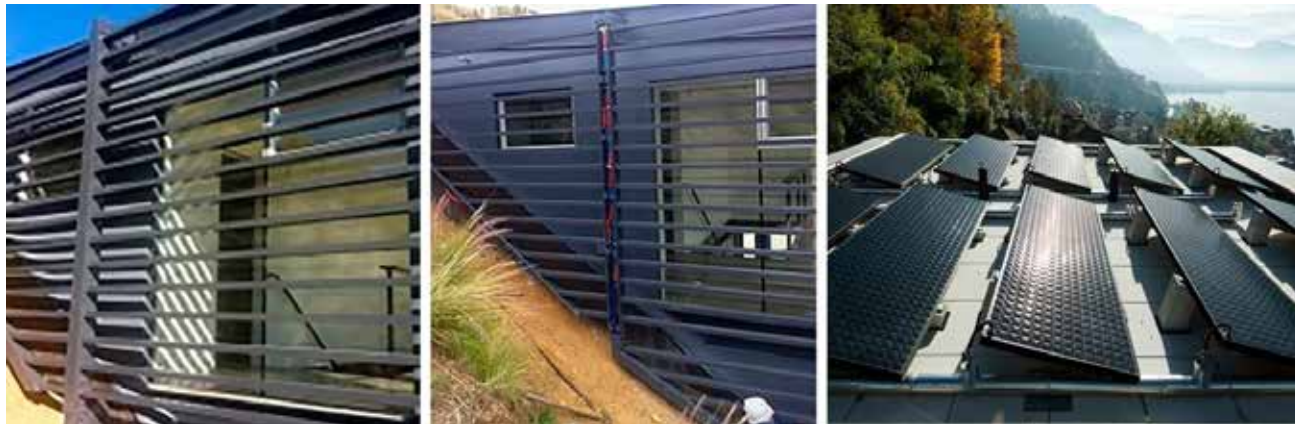
Εικόνα 5 Τυπολογία των Unglazed Flat Plate Hydraulic Collectors με και χωρίς τις εμφανείς σωληνώσεις.
