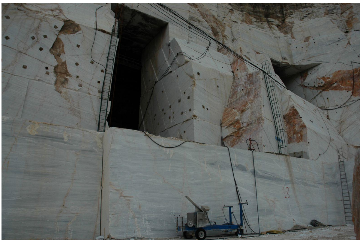
Στοά υπόγειας εξόρυξης σε λατομείο της εταιρείας Dionyssomarble στην Πεντέλη.
