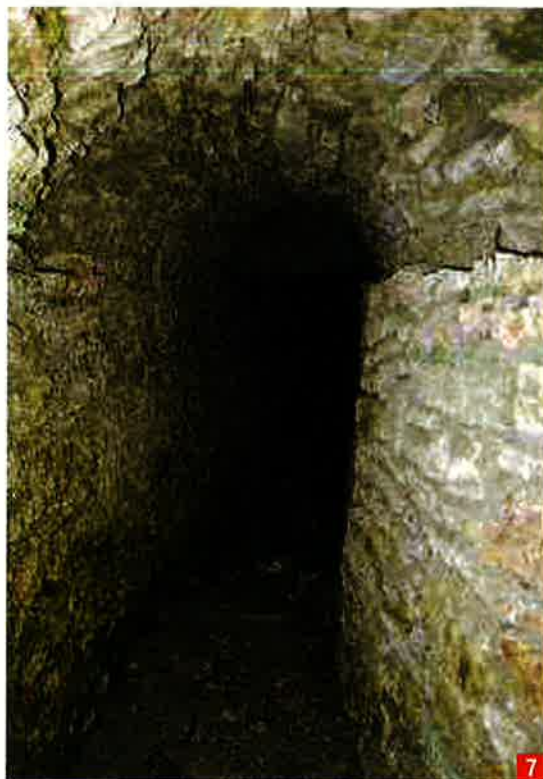
7. Η στήριξη των γαλαριών με αψίδα ή με μονοκόμματα πέτρα (8)
