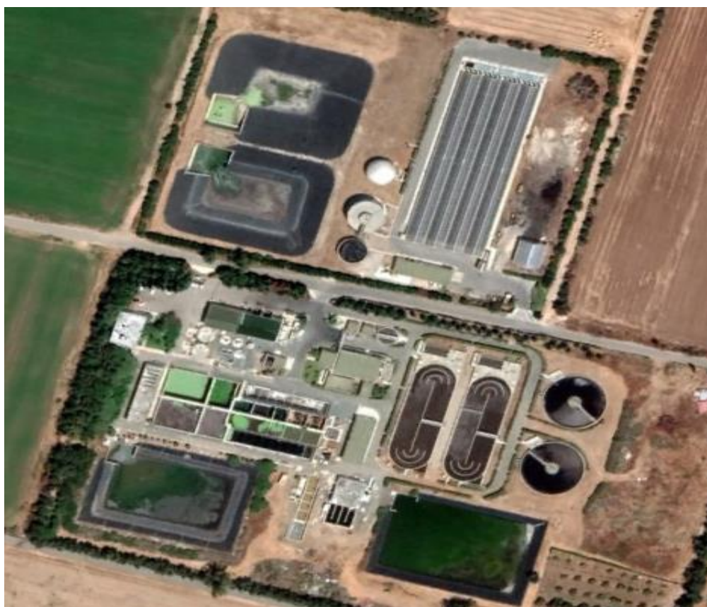
Εικόνα 3: Τωρινή κατάσταση μονάδας.
