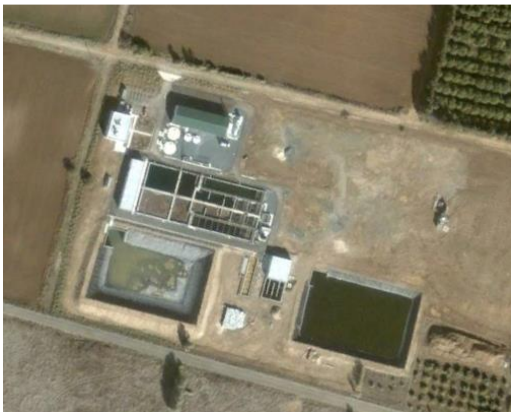
Εικόνα 2: Πρώτη φάση κατασκευής της Μ.Ε.Α.Υ.Α. Πάφου
