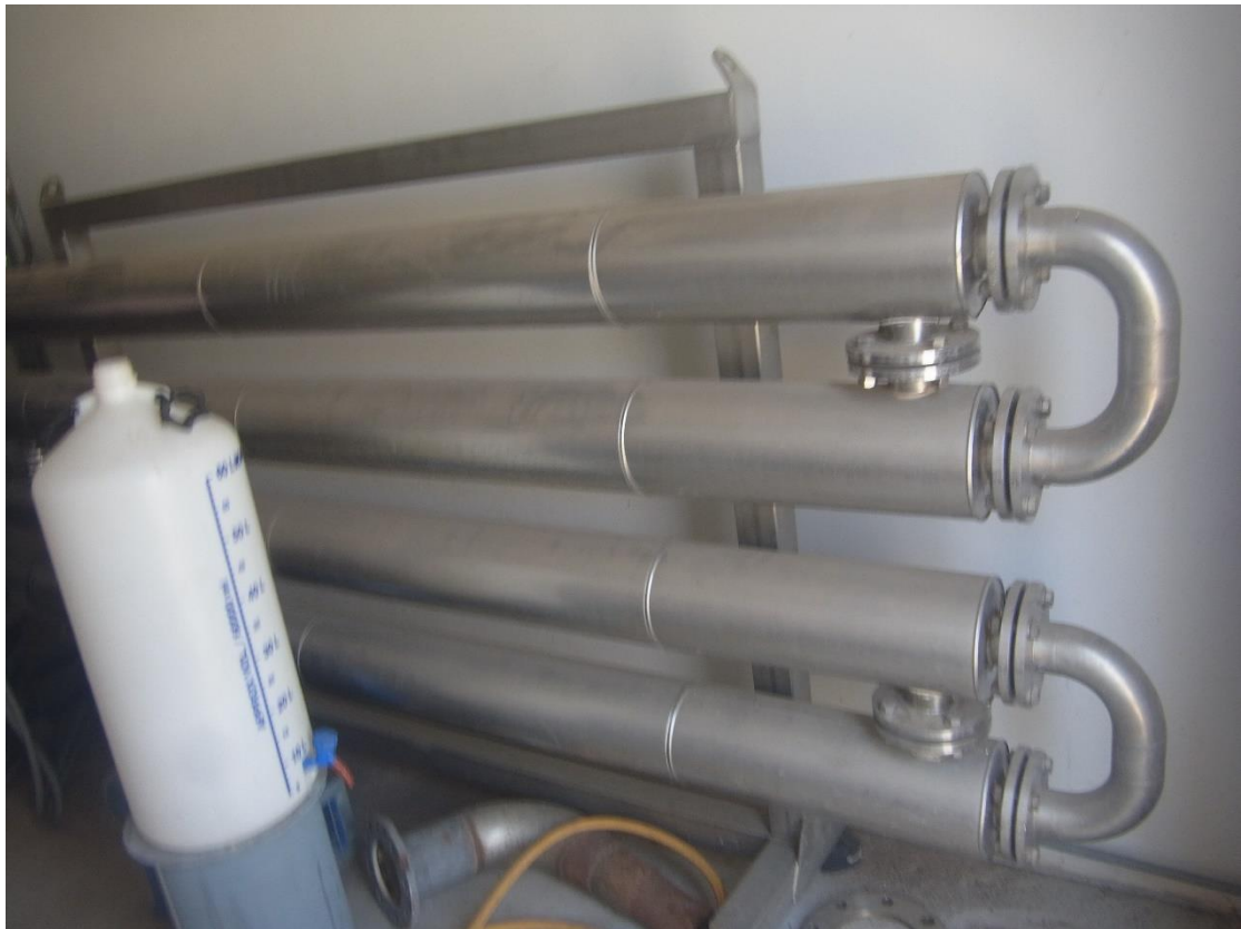
Εικόνα 21: Εγκαταστάσεις επεξεργασίας ιλύος.
