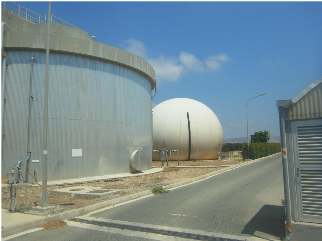
Εικόνα 22: Εγκαταστάσεις επεξεργασίας ιλύος.
