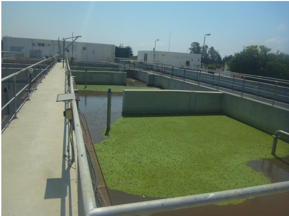
Εικόνα 10: Εγκαταστάσεις βιολογικής επεξεργασίας
