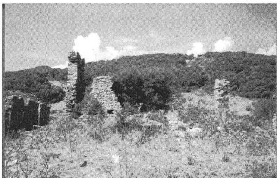
Εικ. 10Α. Κτήριο Α. από Ν: Εικ. 10Α επάνω γύρω στὰ 1966. Εικ. 10Β. τοῦ 1997: διακρίνεται ἡ προϊούσα φθορά, ἰδίως στὸν ἀνατο- λικὸ (δεξιὰ) τοῖχο
