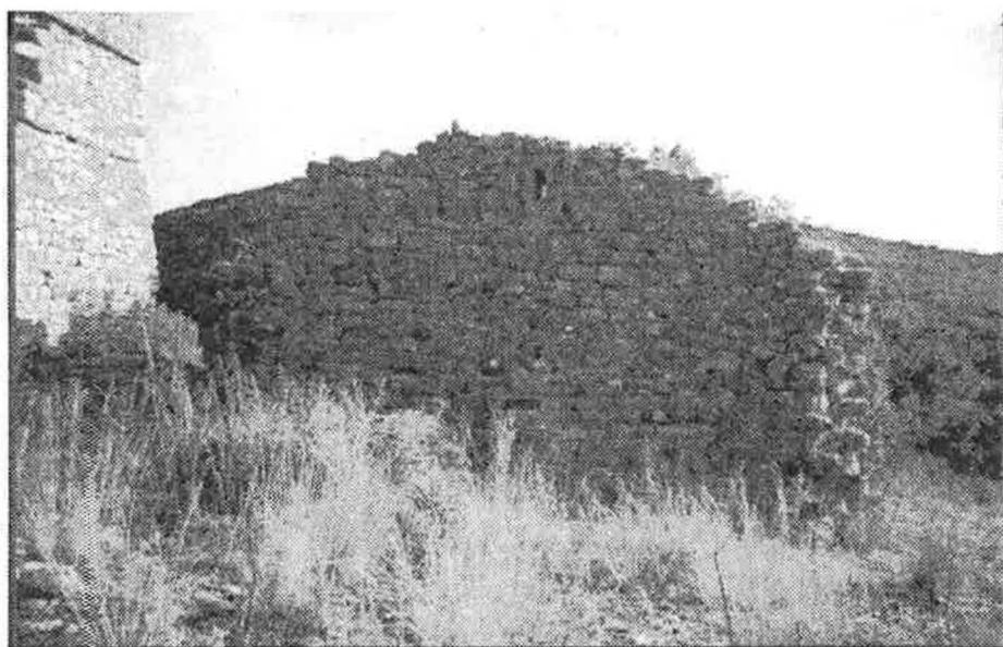
Εικ. 18. Τὸ χαμηλότερο κτήριο Β, δυτικά τοῦ Α (πὸ ὑψώνεται στὰ ἀριστερὰ τῶν εἰκόνων). Εἰκ. 18Α (πάνω): βορειοδυτικὴ – κατὰ προσέγγιση – ἄποψη. Εἰκ. 18Β: Βόρεια πλευρὰ τοῦ κέντρου Β (1997). Πρβλ. εἰκ. 22.
