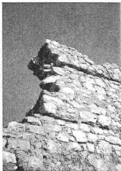
Εικ. 8. Κτήριο Α. Κενά στην τοιχοποιία, όπου υπήρχαν ποτέ οι οριζόντιες ξυλοδεσιές (1997)
