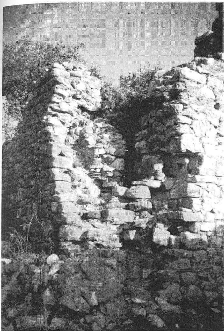
Εἰκ. 9. Ἀφαίρεση γωνιολίθων, κτήριο Α, δυτική γωνία (1997)
