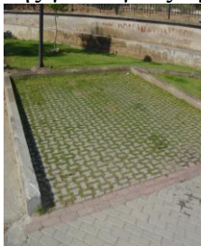
Εικόνα 3: Ενισχυμένο Γρασίδι
