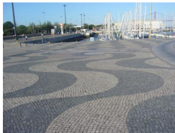
Εικόνα 7: Πλακόστρωτο από κυβόλιθο με γρανιτικά σέτ και δημιουργία σχημάτων
