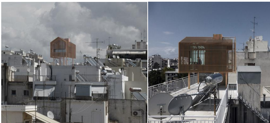
Εικ.7: City rooftop cabin
