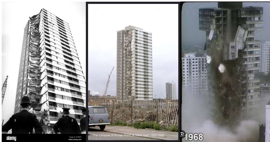
Σχήμα 1.1 Η κατάρρευση του Ronan Point Tower (1968, Λονδίνο, ΗΒ)
