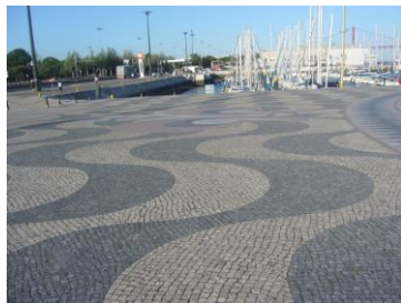
Εικόνα 7: Πλακόστρωτο από κυβόλιθο με γρανιτικά σέτ και δημιουργία σχημάτων
