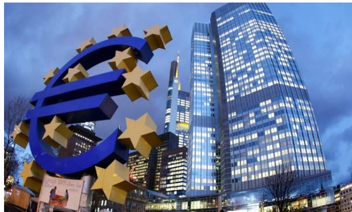
Εικόνα 8: Το κτήριο της Ευρωπαϊκής Κεντρικής Τράπεζας
