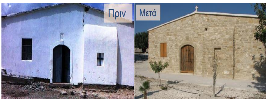
Εικόνες 1&2: Αποκατάσταση Εκκλησίας Αγίου Γεωργίου-Περιοχή Αναδάσμου Χοιροκοιτίας
