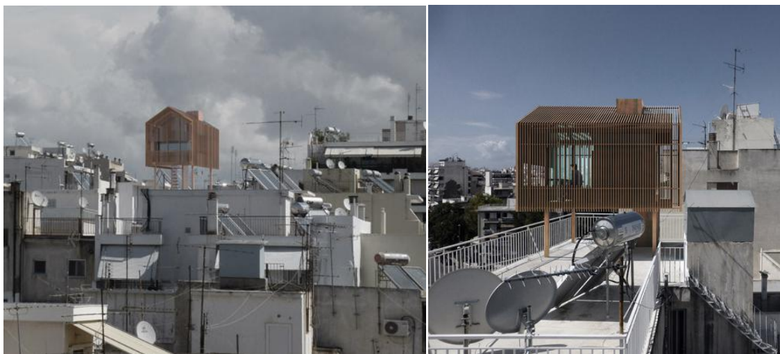
Εικ.7: City rooftop cabin
