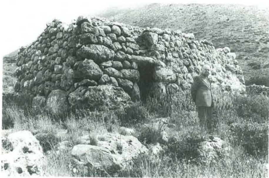
Εικ. 8β. Μάνη, Μίνα: Άι-Γιάννης στον Κοράκον. Ογκολιθική τοιχοδομία (φωτ. Αρχείο Ν. Β. Δραυνιάκη, φ. 133, 1984)
