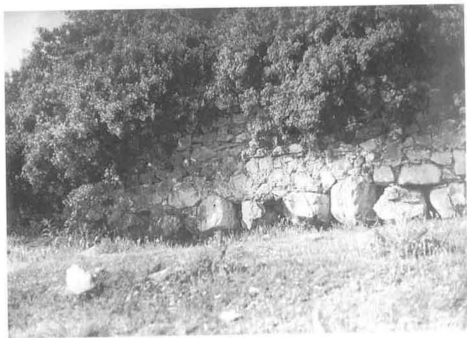
Εικ. 7. Η βάση της Ν πλευράς του συγκροτήματος των κελιών.
