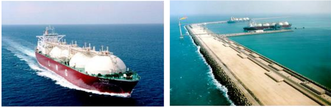
Εικόνα 3: Αριστερά(α) ειδικά κατασκευασμένο δεξαμενόπλοιο για μεταφορά υγροποιημένου Φ.Α.-LNG και δεξιά(β) σταθμοί εκφόρτωσης. 5
