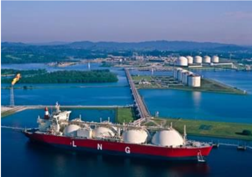
Εικόνα 4: Ειδικά κατασκευασμένο δεξαμενόπλοιο για μεταφορά υγροποιημένου Φ.Α.-LNG και στο βάθος της εικόνας οι δεξαμενές αποθήκευσης και ο τερματικός σταθμός απουγροποίησης. 6
